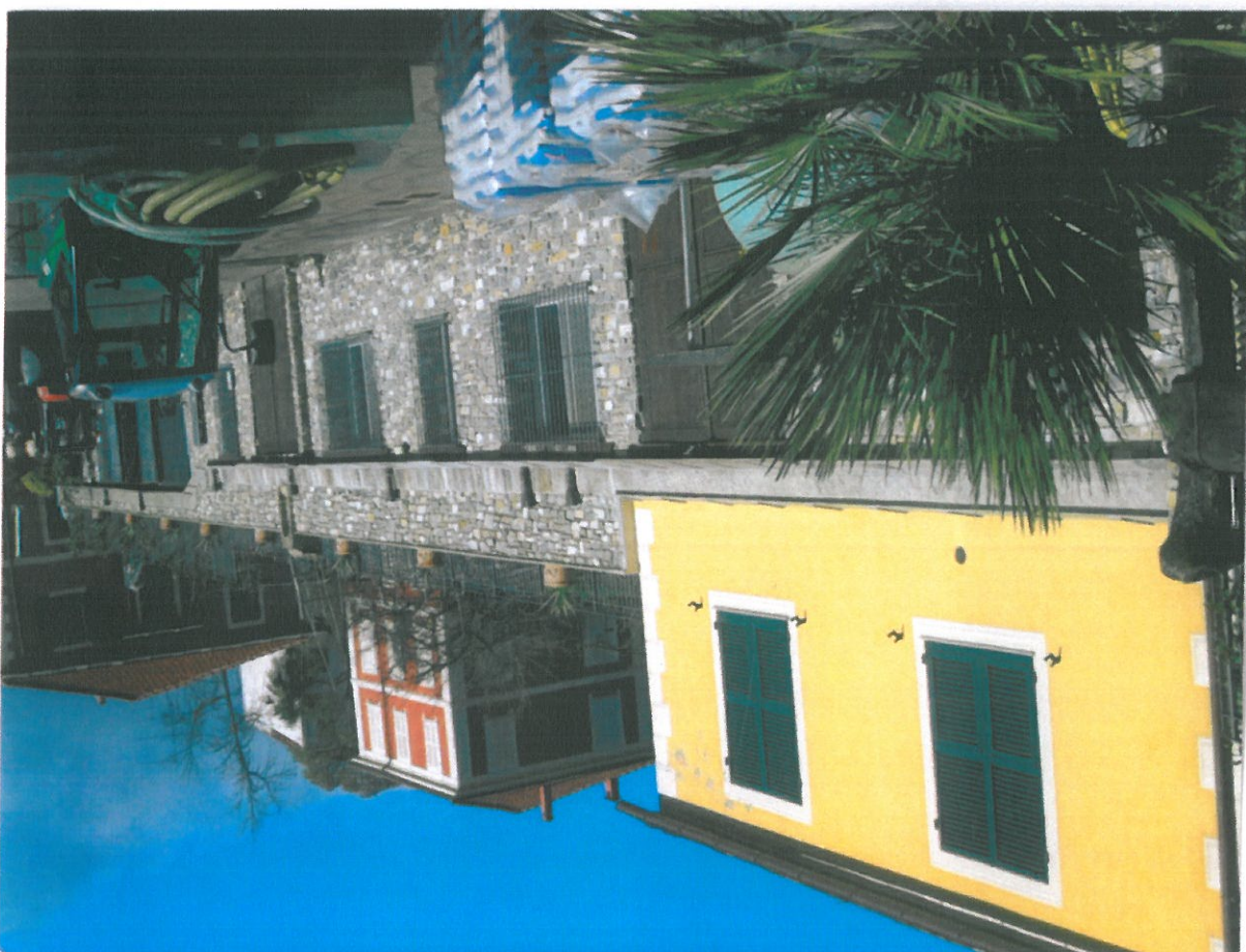
Foto 3 - Vista frontale del fabbricato A
